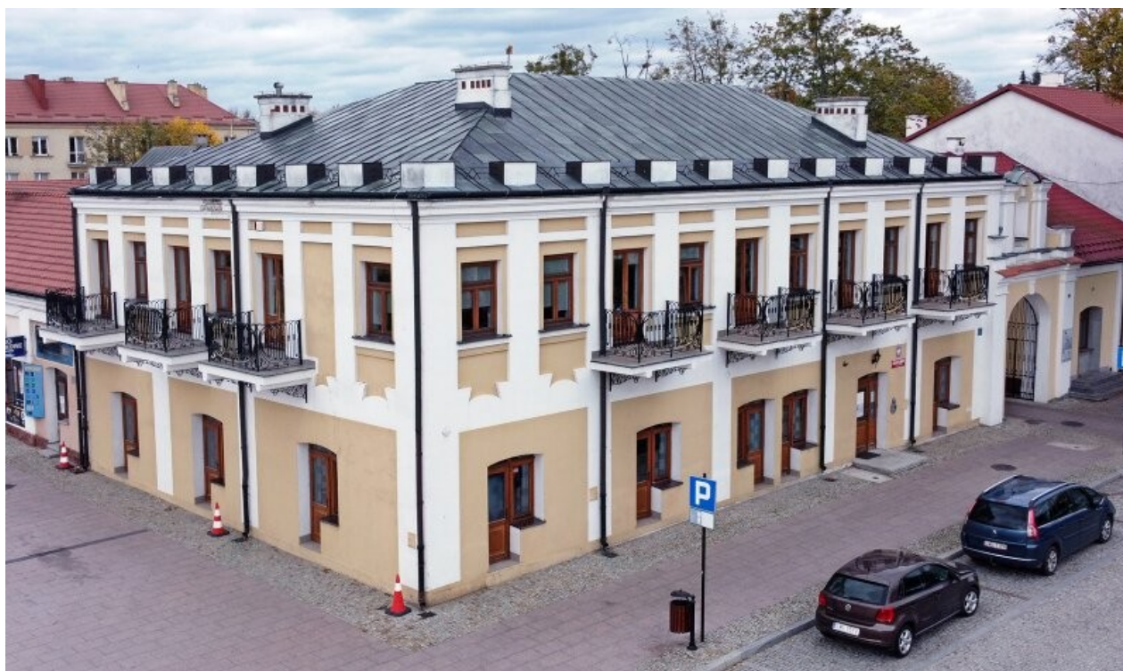
Budynek Urzędu Skarbowego we Włodawie. Widok od strony południowo-wschodniej.
