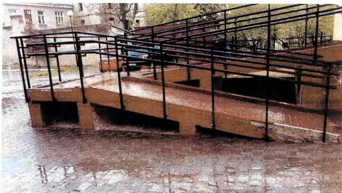
Foto 3. Widok podjazdu od południa
