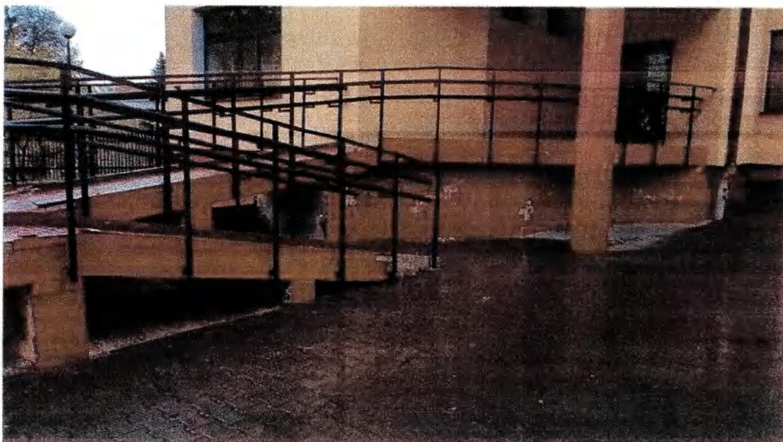
Foto 2. Widok podjazdu od południa
